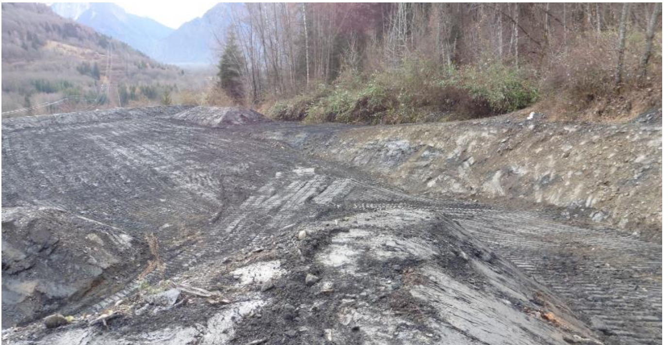
Figure 7 : Terrassements réalisés sur la partie haute des anciennes ardoisières pour le stockage des crues solides (charriage) des Rivets et de Mondane.
